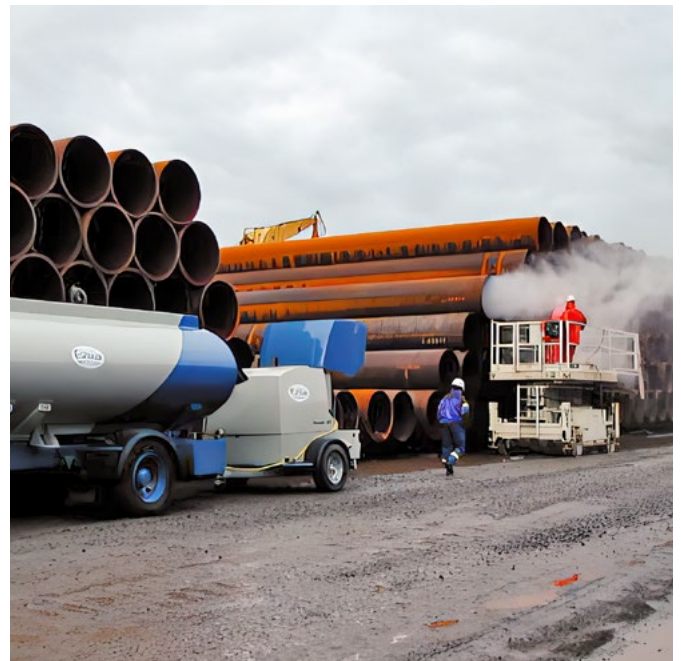
Reinigung von Pipelinerohren Cleaning pipelines Nettoyage des tuyaux pipeline
