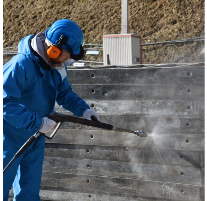
Reinigung von Schalungen Cleaning shuttering Nettoyage des coffrages
